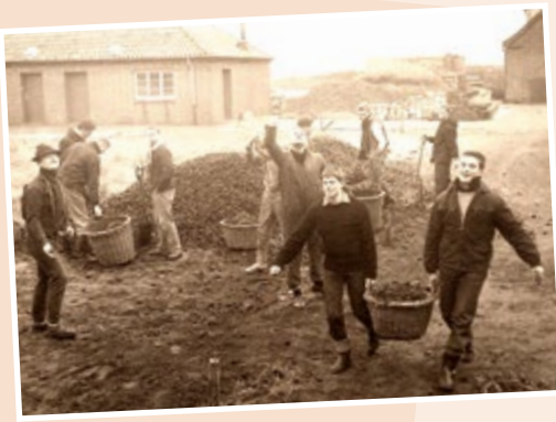
Arbeiten mit Koks: Lodde, Bode, Grundt, Klinkott, Sommer, Behrens, Vogt, Schifferdecker, Bauer, Ohse, Eckert
