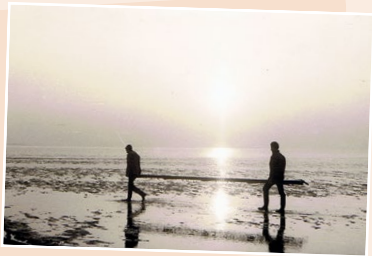
Die Gleise werden verlegt
